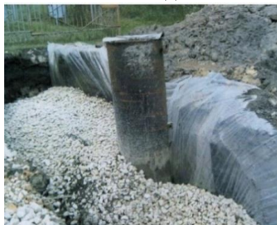
Рис. 2.4 – а) Устройство дрены б) Замеры уровней воды и углеводородов в скважине
